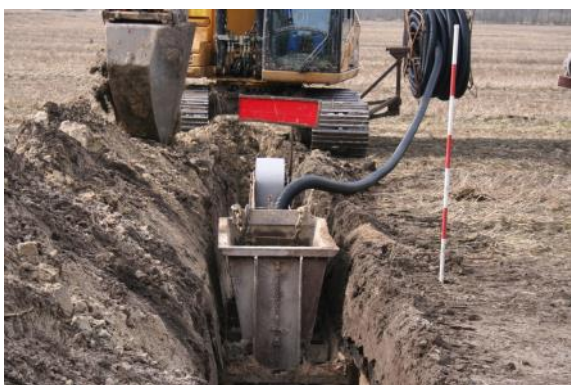
Dræning med almindelig gravemaskine og drænkasse. Foto: Janne Aalborg Nielsen, SEGES.
