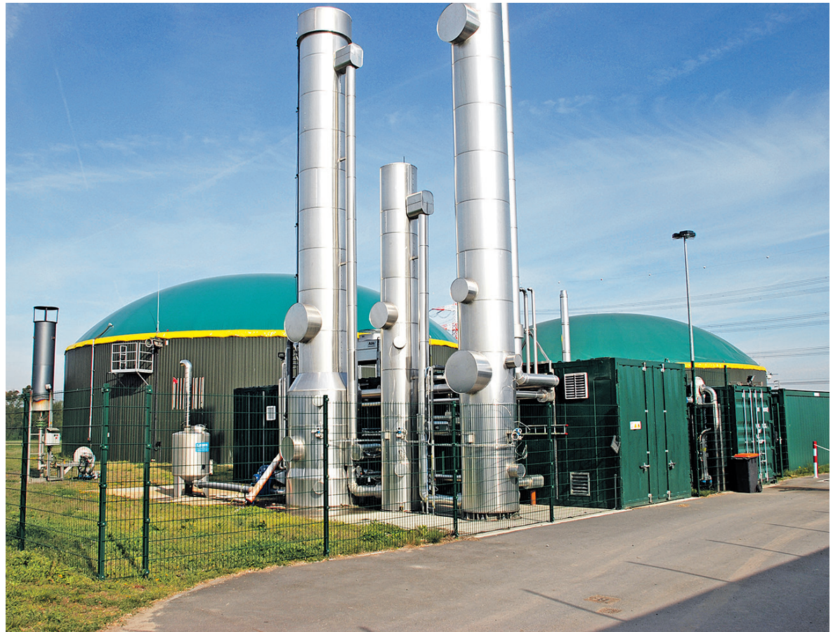
Gårdbiogasanlæg med anlæg til opgradering af biogas til naturgasnettet. Foto: Michael Tersbøl.
