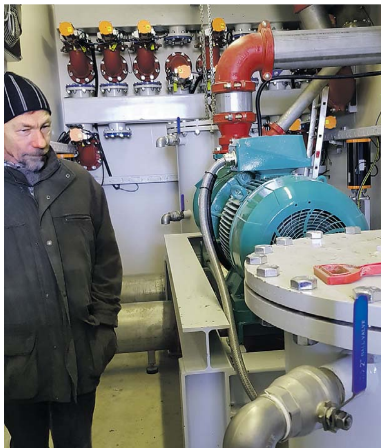
Pumpen cirkulerer den flydende afgassede biomasse, som via sprinklere sprøjtes ud over flydelaget i de to reaktorer.
