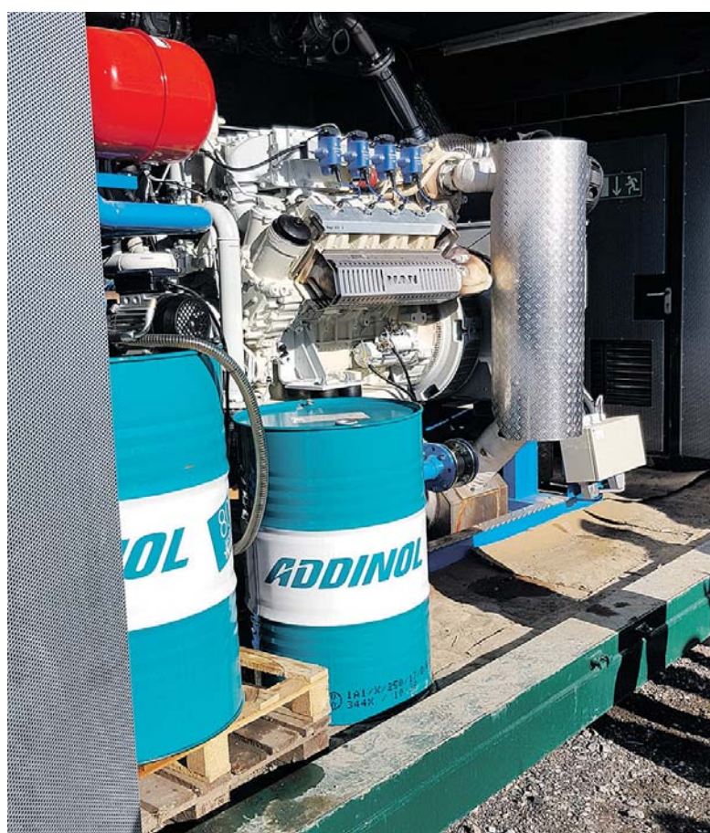
Biogassen afbrændes i en generator og bliver til elektricitet, som sælges til Seas.
