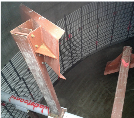
Kraftige, lodretgående padler er velegnede til anlæg der benytter faste biogasmasser
