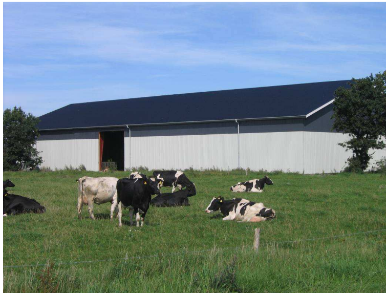
Figur 4. Det samlede anlæg er bygget ind i en ny hal.
