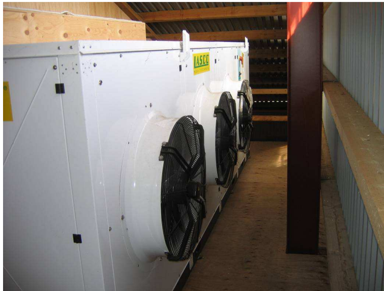
Figur 7. Affugteren, der også er varmepumpe.
