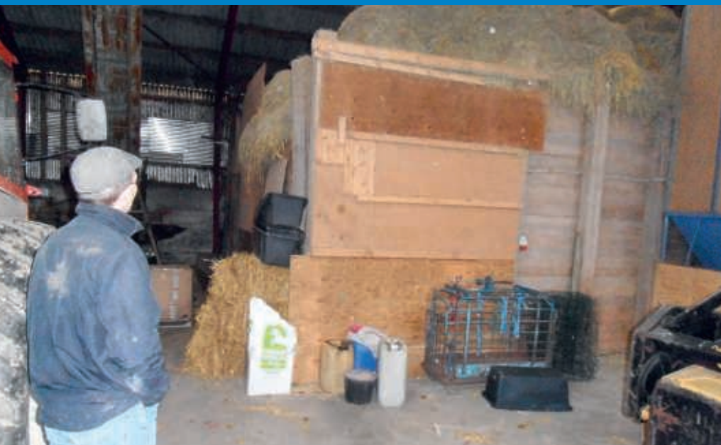
Morten har omdannet et korntørringsanlæg i laden, så det kan bruges til at ladetørre græs til hø.
