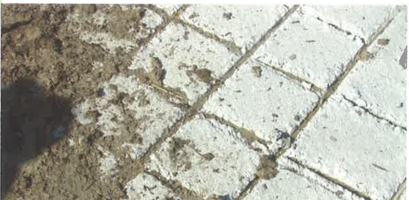
■ Store riller i betonen sikrer et skridsikkert underlag til Jeff Braggs malkekøer.
