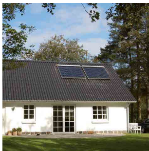
Solfangeranlæg i Bindeballe. Foto Wellmore A/S.
