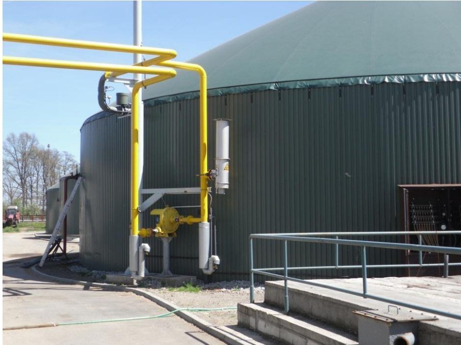
Figur 39: Start af biogasrør til et satellit-kraftvarmeværk for byen Trebon, Tjekkiet (Kilde: D. Rutz)
