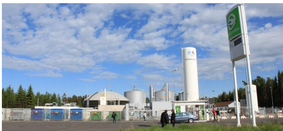
Figur 44: Svensk Biogas Internationals biogasanlæg, der producerer LBG i Linköping, Sverige (Kilde: Rutz)
