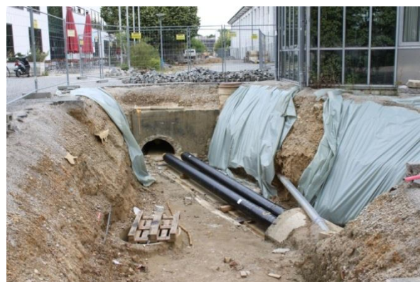
Figur 14: Opførelse af et fjernvarmesystem i Tyskland (Kilde: Rutz)
