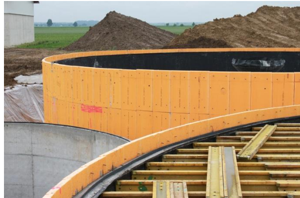
Figur 7: Isolering (orange paneler) af rådnetanke i Reichenkirchen, Tyskland (Kilde: Rutz)
