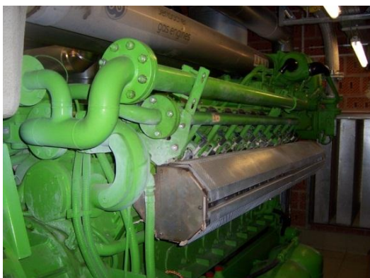
Figur 8: Gas-Otto motor på et biogasanlæg i Tyskland (Kilde: Rutz)
