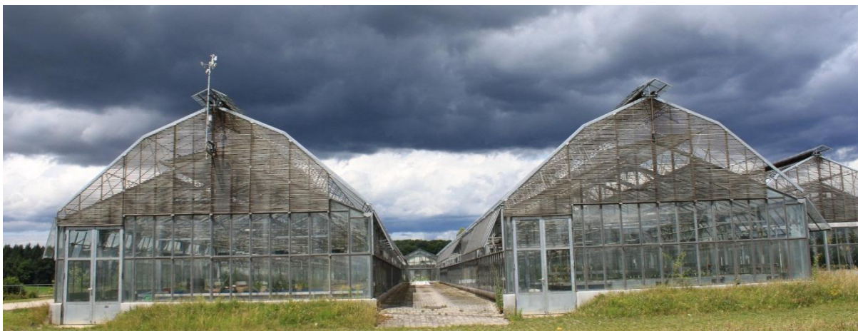
Figur 19: Akklimatiserede glasdrivhuse i Tyskland (Kilde: Rutz)
