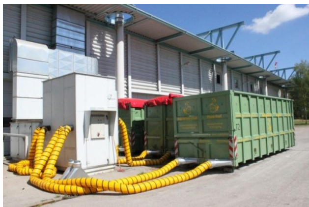
Figur 27: Container og opvarmningsrør til tørring af træflis på et biogasanlæg i München, Tyskland (Kilde: Rutz)
