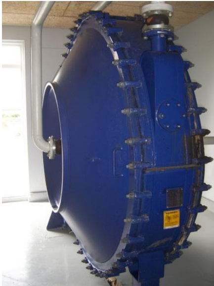
Figur 15: Spiral varmeveksler i Danmark (Kilde: Rutz)
