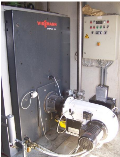
Figur 1: Biogasbrænder i Østrig (Kilde: Rutz)
