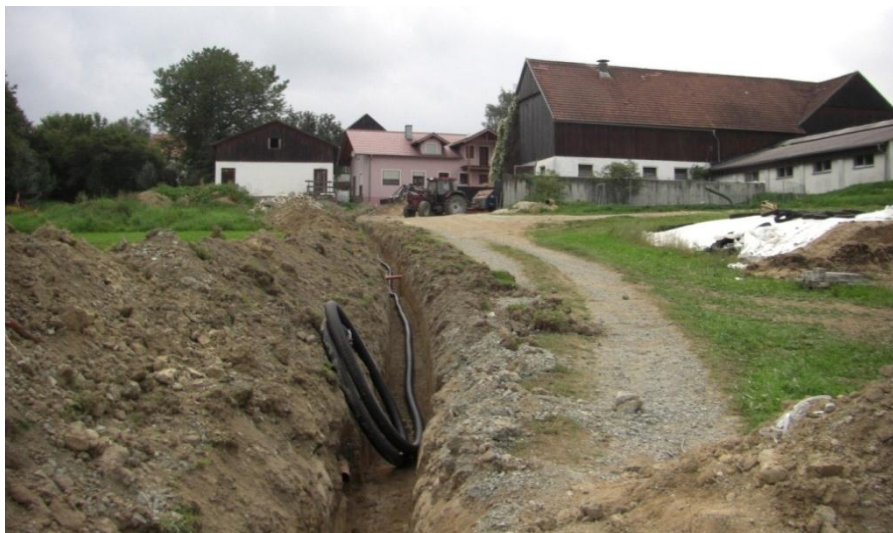
Figur 12: Installation af en varmerørledning til en gårds bygninger (Kilde: Thermaflex Isolierprodukte GmbH)
