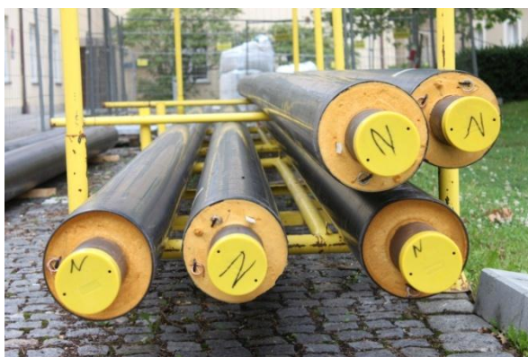
Figur 13: Isolerede rør til fjernvarme i Tyskland (Kilde: Rutz)
