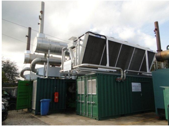
Figur 33: ORC system (bruger R245fa) (forreste container) og biogas motorer (bagerste container) på en losseplads i Warrington, U.K. (Kilde: Verdesis Services UK Limited)
