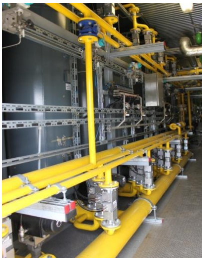
Figur 41: Tryk Udsvings Absorptions (PSA) teknologi i Aiterhofen, Tyskland (Kilde: Rutz)
