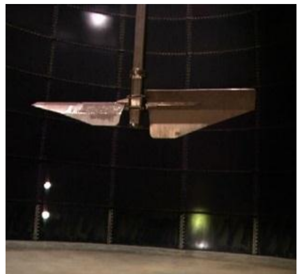
Figure 2: Eksempel på central/axial omrøring (billedet er ikke fra Millers anlæg). Photo: DLZ
