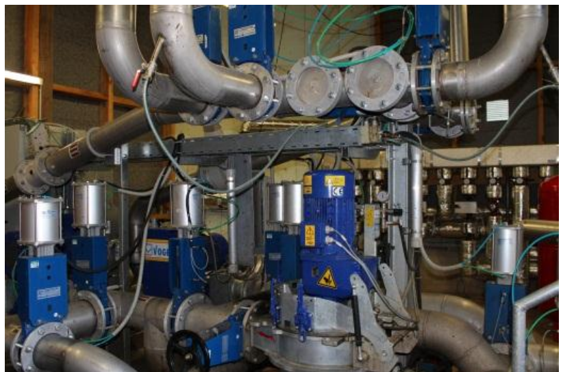
Figure 7: Pumper og rør mellem reaktorerne
