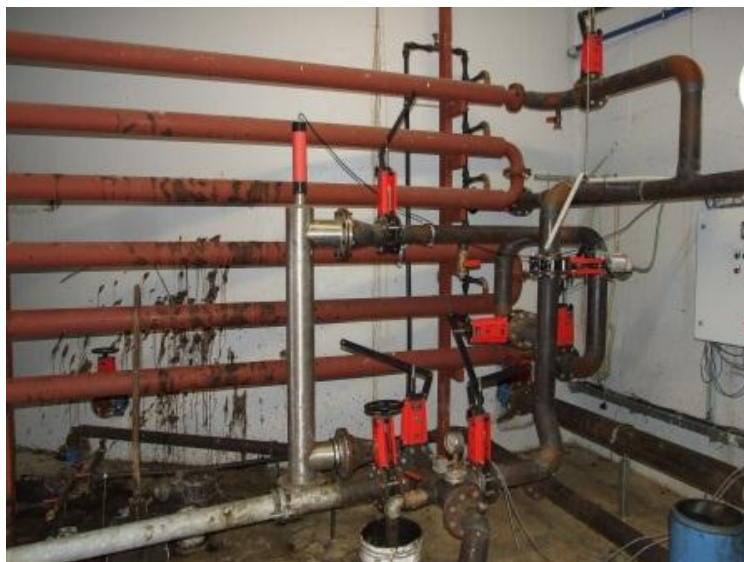
Figure 3: Ekstern varmeveksler til biomassen.
