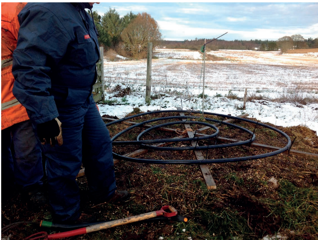
FIGUR 8: PEL-slanger monteret på lægter.
