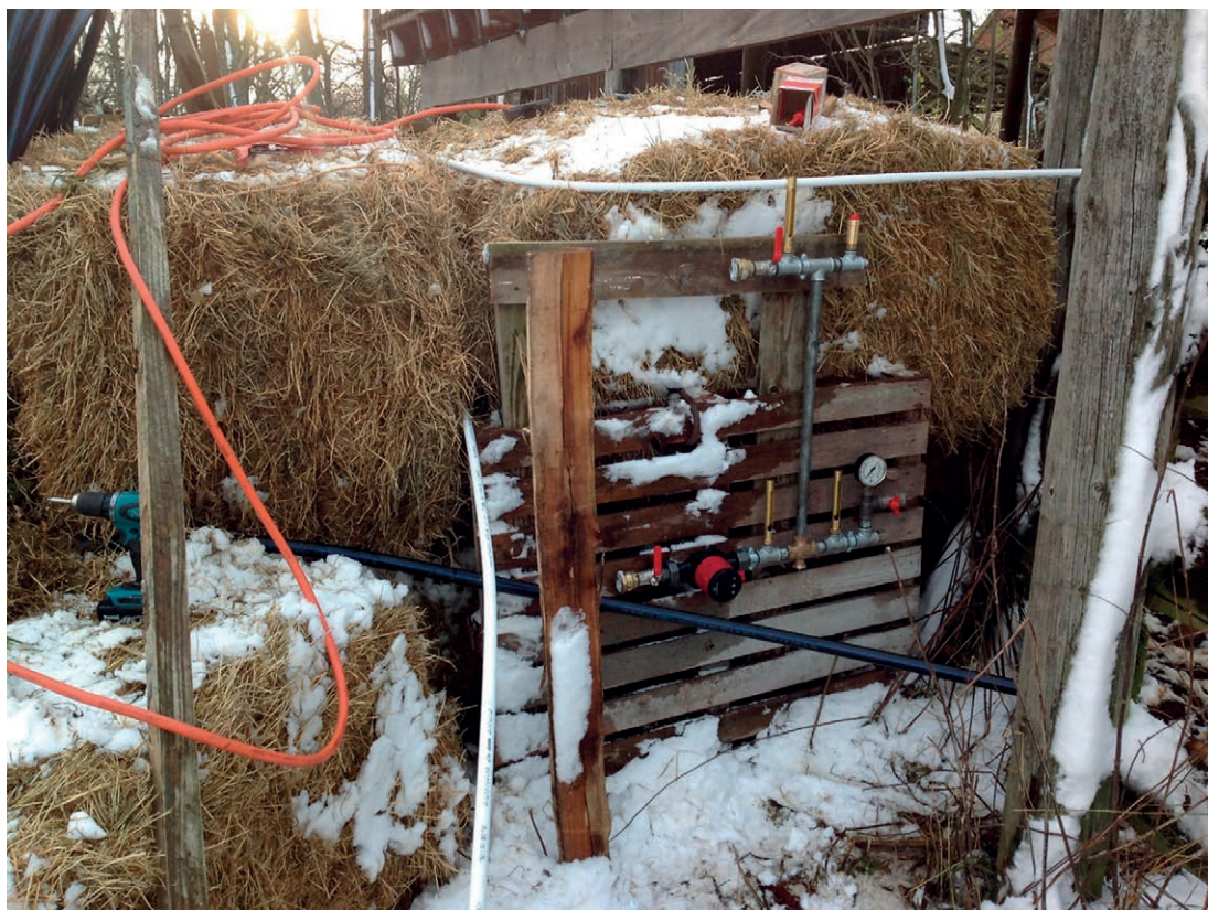
FIGUR 9: Den færdige biomi- le med påbegyndt opsætning af VVS-installationer.
