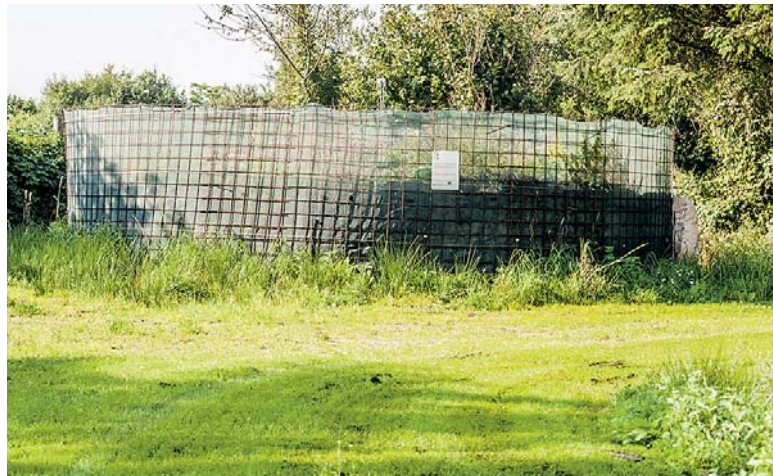
Det store kompostvarmeanlæg på Almende, som blev etableret den 1. marts i år af groft poppeflis og dybstrøelse. Kompostbunken var 0,5 meter over netets kant ved etablering og i løbet af de mellemliggende 5-6 måneder er den sunket ca. 1,5 meter i højden.
