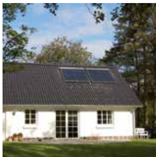
Solfangeranlæg i Bindeballe. Foto Wellmore A/S.
